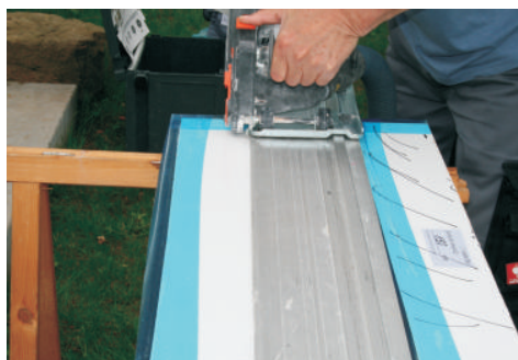
Možnost zkrácení na stavbě
